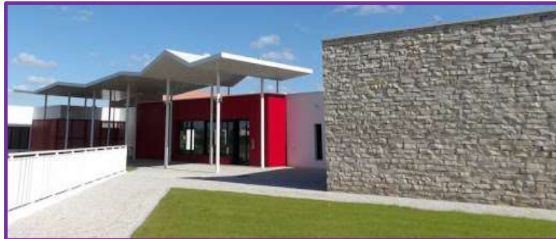
Entrée du Vill'Âges à Dompierre
